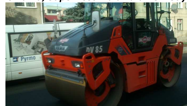
Zagęszczanie warstwy ścieralnej.
