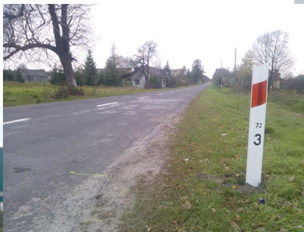
Zdegradowany odcinek drogi w Województwie Lubelskim.
