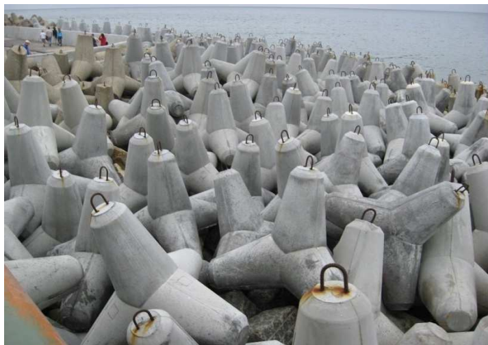
Typowy falochron z gwiazdobluków.
