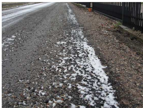
Odcinek drogi Śmiechów – Gąski.
