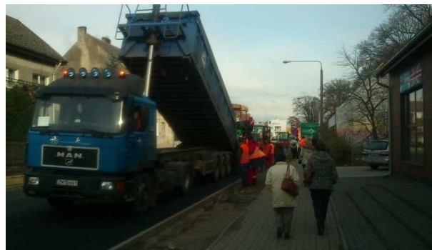
Rozkładanie masy mineralno-bitumicznej na odcinku drogi wojewódzkiej nr 151 Barlinek.
