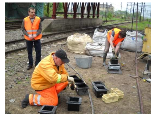
Betonowanie dr 163 Białogard.
