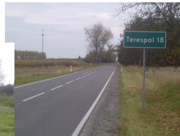
Odcinek drogi w zadowalającym stanie technicznym.
