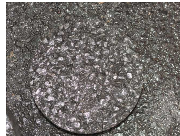
Odwiercona próbka warstwy wyrównawczej i wiążącej Ø 200 mm.
